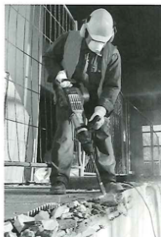
床面のコンクリート破つりに。
