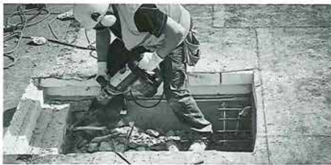
床の古くて硬いコンクリートの破つりに。
